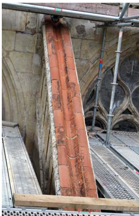
Canal d'évacuation des eaux sur un arc-boutant de Notre-Dame-des-Marais, église de La Ferté-Bernard.
