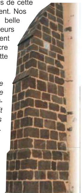
Église de Valennes: contrefort.
